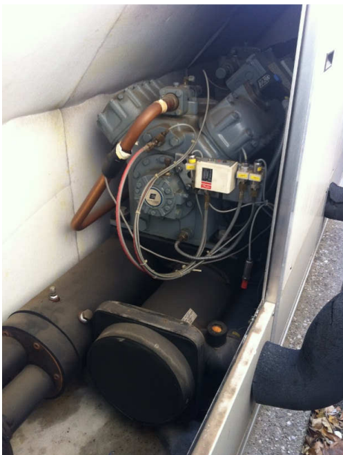
Compresor semi-hermético con los intercambiadores
